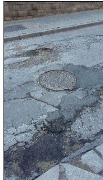
Figura 2: Pozo en inicio de actuación
