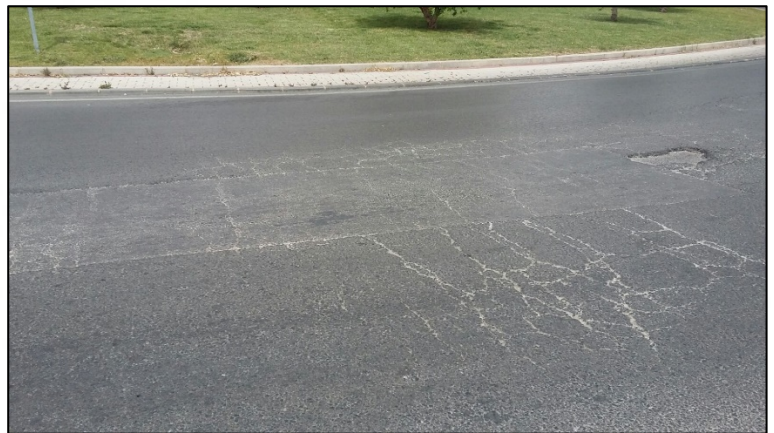
Figura 2: Aglomerado deteriorado
