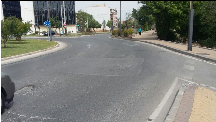
Figura 1: Estado actual de la rotonda
