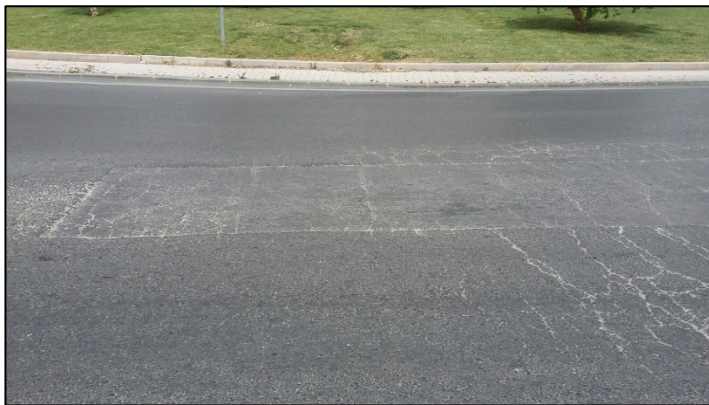
Figura 3: Aglomerado deteriorado
