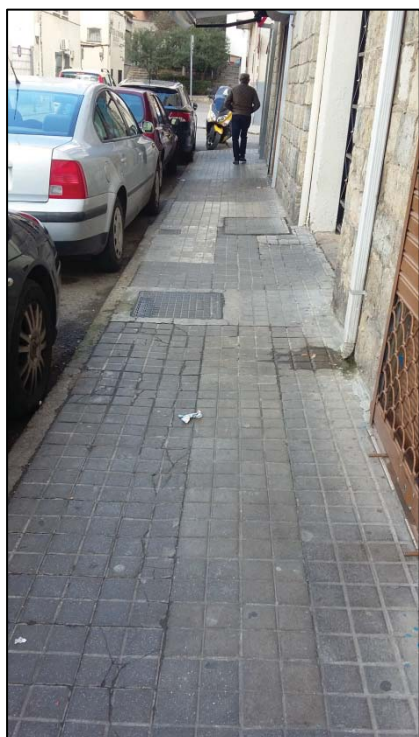
Figura 1: Estado actual de la zona de actuación
