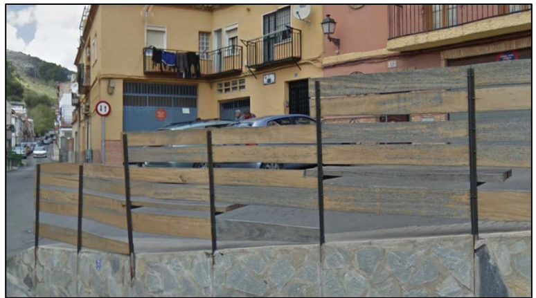
Figura 2: Banco deteriorado trasera
