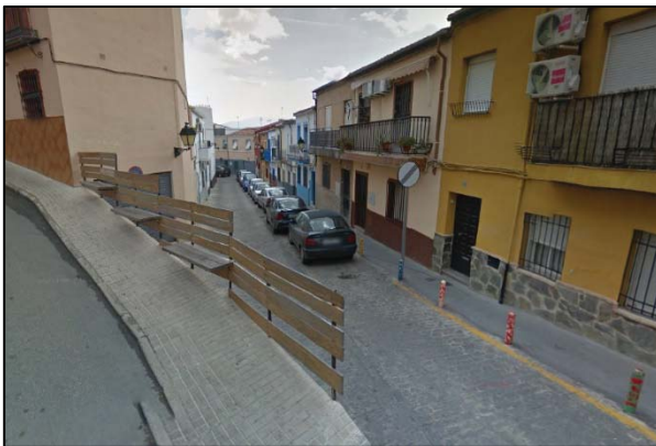
Figura 3: Banco deteriorado parte delantera
