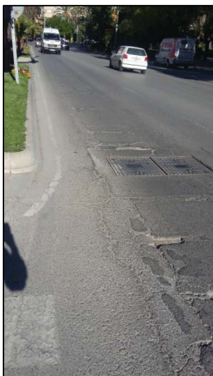
Figura 3: Situación Arqueta en calle
