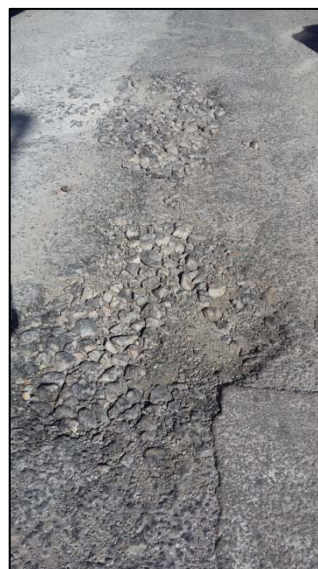
Figura 2: Aglomerado deteriorado
