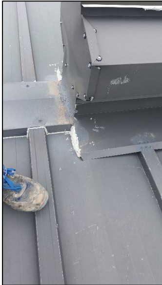
Estado de las juntas, paneles y encuentros de la cubierta
