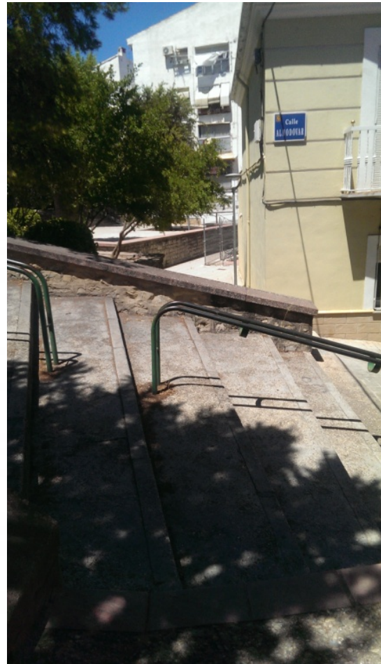
Figura 2: Zona de intercesión de rampas con escaleras
