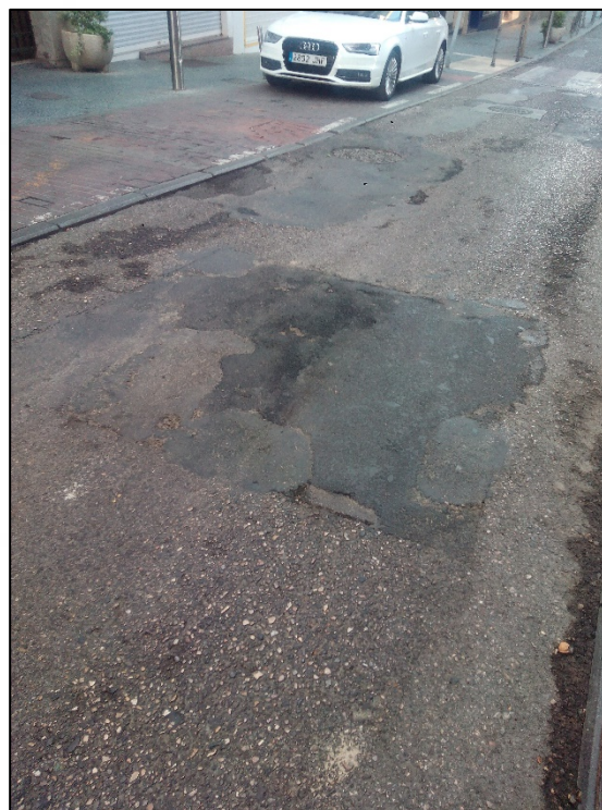
Figura 2: Aglomerado deteriorado
