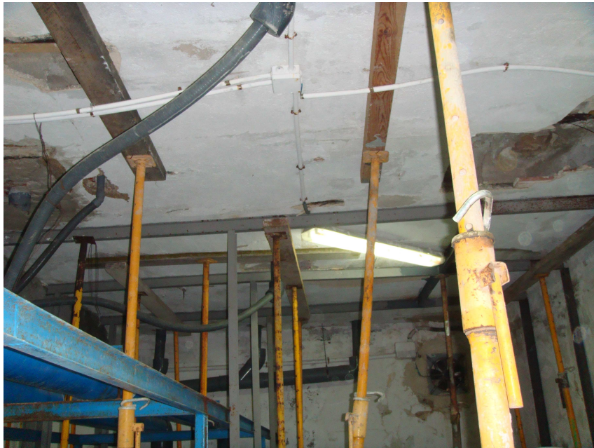
Detalle de la cruzía izquierda con estructuras de apuntalamiento metálicas antiguas.
