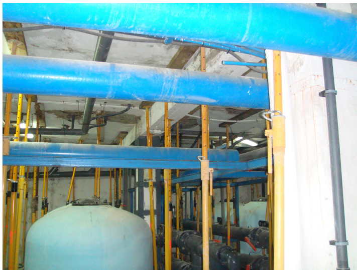
Vista de los dos primeros tramos del pórtico central
