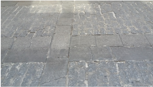
Figura 1: Estado actual de la calle Bernabé Soriano
