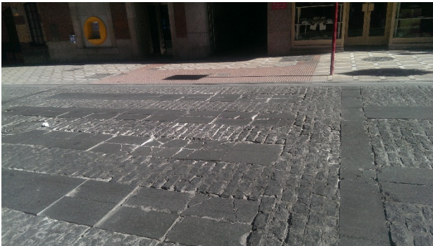
Figura 3: Estado actual de la calle Bernabé Soriano
