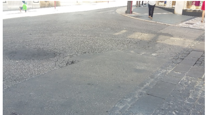
Figura 2: Estado actual de la calle Bernabé Soriano
