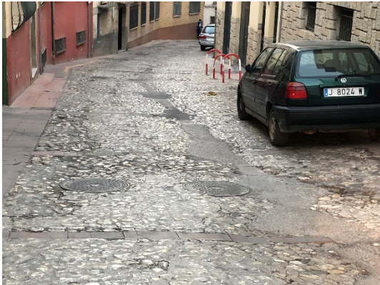
Figura 1: Estado actual de la calle
