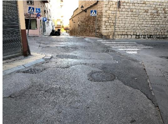
*Figura 2: Hundimientos de pavimento*
