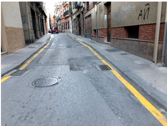
Figura 3: Pozo de registro
