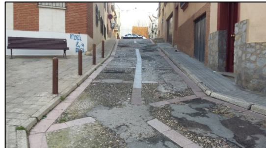
Figura 2: Estado actual Acceso hacia Plaza Cambil.
