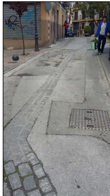
Figura 2: Estado actual Acceso
